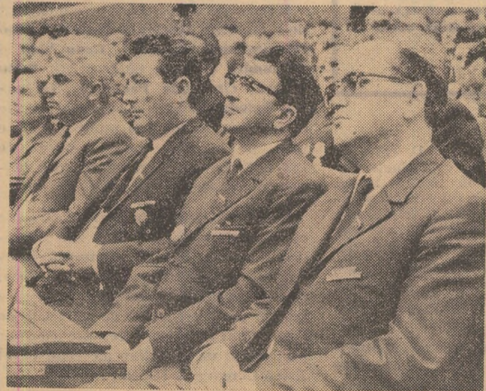
În timpul lucrărilor...
