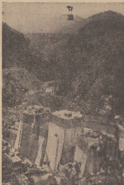
Aspect de la barajul Pallinu, județul Prahova, aflat în plină construcție. Apa lacului de acumulare ce se va crea aici va fi folosită și pentru irigații
