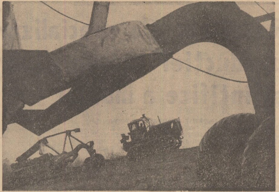
„Asaltul” pămînturilor. Imagine de lucru de pe șantierul de desecări de la Potelu, județul Olt.
