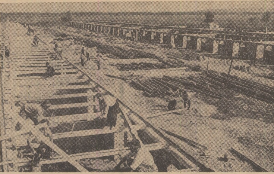
La Gîrla Mare, județul Mehedinți, se pun bazele unuia dintre primele obiective zootehnice — rod al colaborării intercooperatiste: Complexul de creștere și îngrășare a porcilor, cu o capacitate de 10 000 de porci pe an
