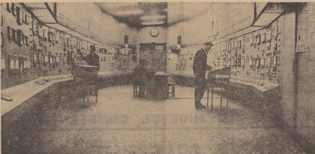
Procesul de producție la combinatul de îngrășăminte azotoase de la Tg. Mureș este aproape în întregime automatizat. În fotografie: aspect de la tabloul de comandă a instalației de cracare a gazului metan.
