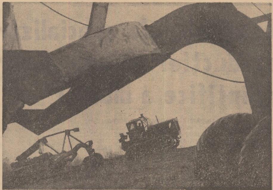
„Asaltul” pământurilor. Imagine de lucru de pe șantierul de desecări de la Potelu, județul Olt.
