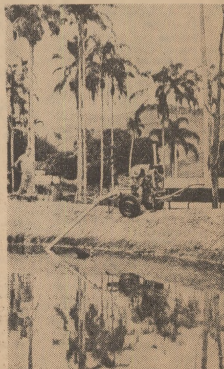
Firma Perrot a creat un tip de motopompă echipată cu motor Diesel, avînd răciră cu aer. Iată-o la lucru în Brazilia
