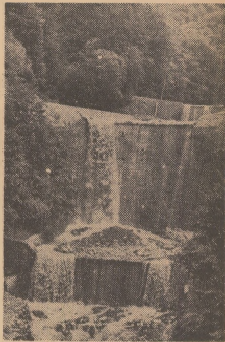
Lucrări de combatere a eroziunii solului în păduri.
