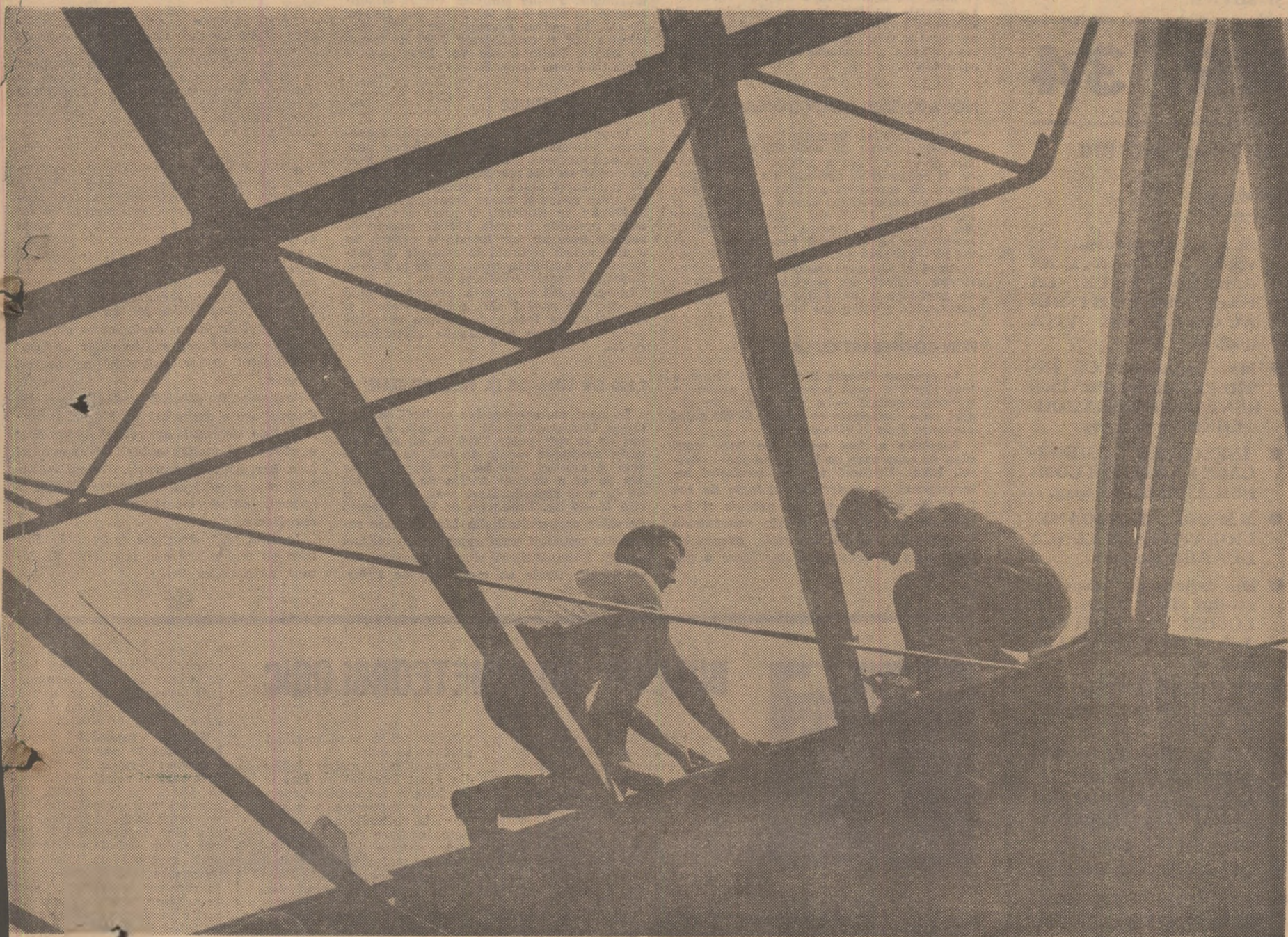
La Sintana, județul Arad, se află în construcție un complex intercooperatist pentru îngrășarea berbecuților. Fotoreporterul i-a surprins pe constructori în momentul în care montau elementele prefabricate din azbociment la aco perișul ultimului tronson al complexului.
