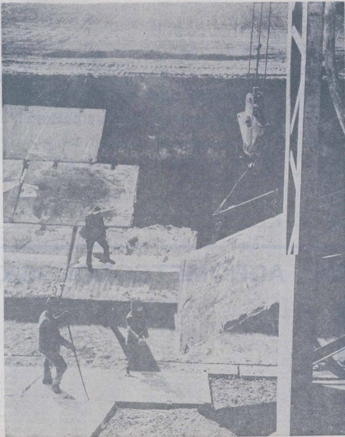
Pe șantierul de irigații Gălățui-Călărăși, județul Ialomița, se montează dalele de beton la canalul principal de aducțiune, care se întinde pe o lungime de 85 km.
