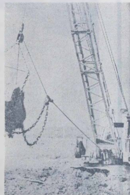
Deși ne aflăm în plin sezon rece, lucrările de hidroameliorații continuă cu intensitate pe șantierul Bîrsa-Vulcănița, din județul Brașov.
