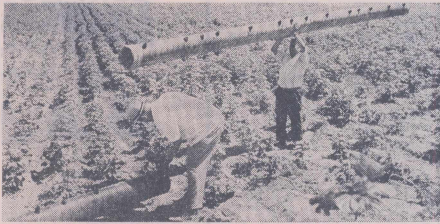
În cadrul preocupărilor consacrate irigației bumbacului, institutul științific de specialitate din Akkavak a creat un nou tip de conducte semisolidă din polietilenă armată cu plasă metalică. Un tronson lung de 6 m cîntărește numai 20 kg.
