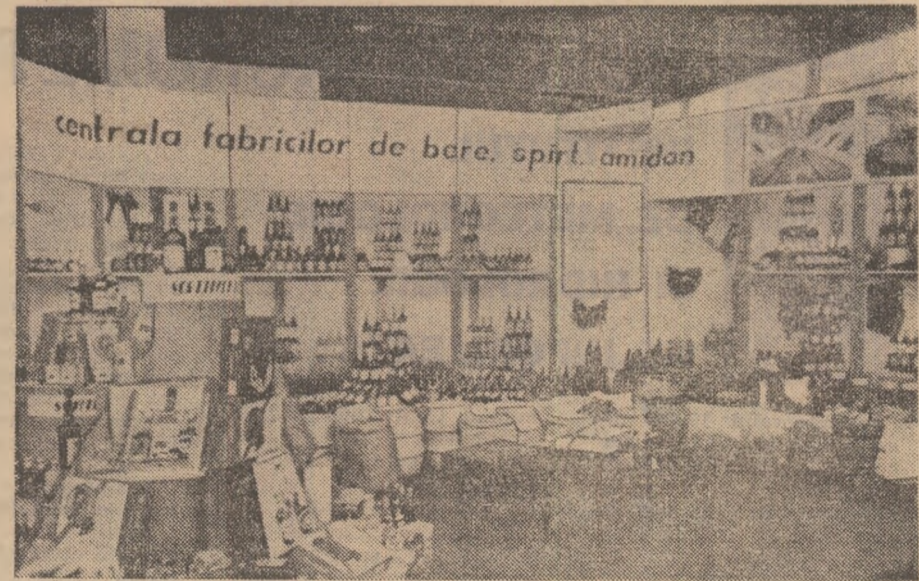
Aspect al unui din standurile Centralei
