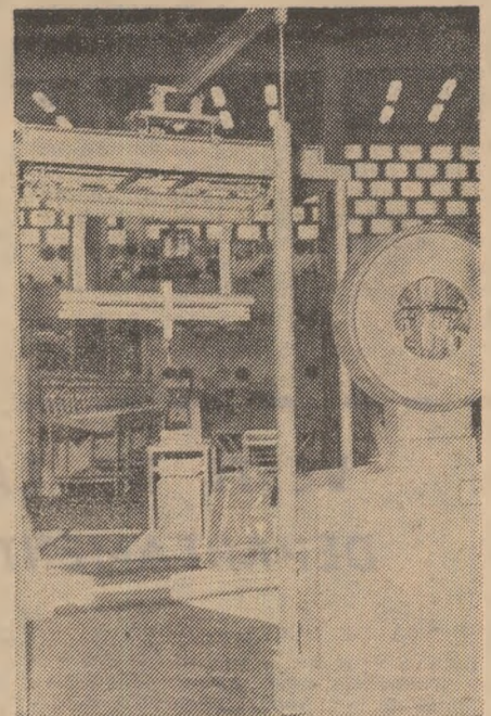
Basculă semiautomată pentru calea aeriană. Sarcină maximă de cîntărire 750 kg.
