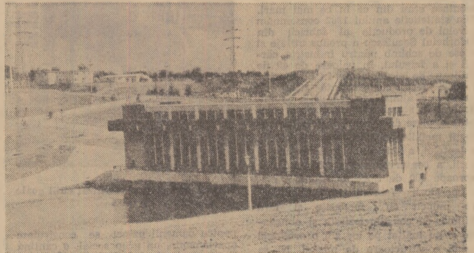
Setea milenară a Bărăganului a fost „potolită” pe zeci de mii de hectare. Unul din avansurile prin care omul a învins natura este și Stația de pompare de la Vlad Tepeș, județul Ialomița, prezentată în imagine; cu ajutorul ei apele bătrînului Danubiu sînt dirijate spre cîmpurile măcoase
