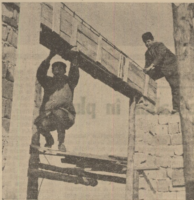
Pentru secția de mecanizare a S.M.A. Găneasa, care deservește cooperativa agricolă din Piatra, județul Olt, se construiește un atelier modern de reparații. În cursul iernii, tractoriștii de aci vor putea lucra la pregătirea utilajelor pentru campania de primăvară, în condiții optime
