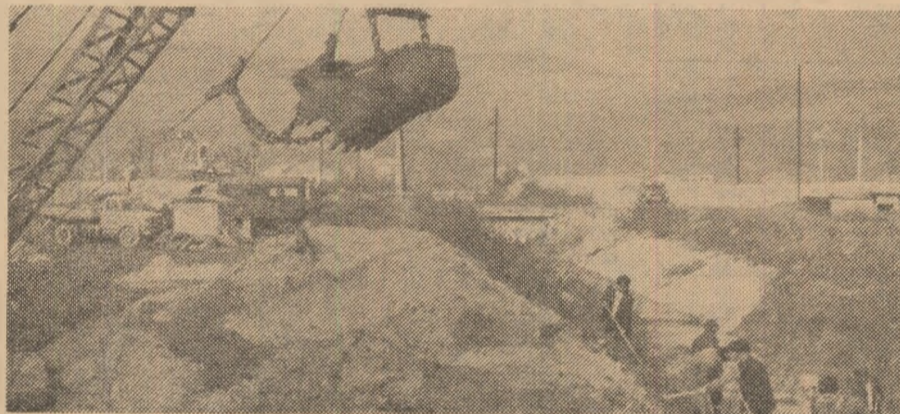
Pe șantierul de îmbunătățiri funciare din comunele Topoloveni, Călinești și Ștefănești, județul Argeș, ritmul de execuție a lucrărilor se intensifică.
