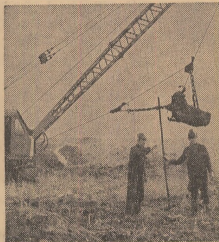
Pe șantierul de desecări Albești-Cloreni, județul Prahova, se intensifică ritmul lucrărilor hidroameliorative.
