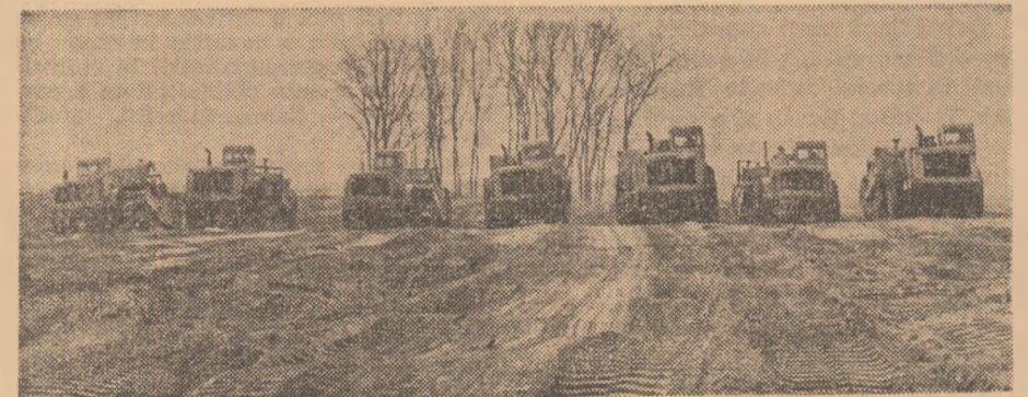
Puternice utilaje acționînd la nivelarea terenurilor, pe șantierul de la Sadova-Corabia, județul Olț.
