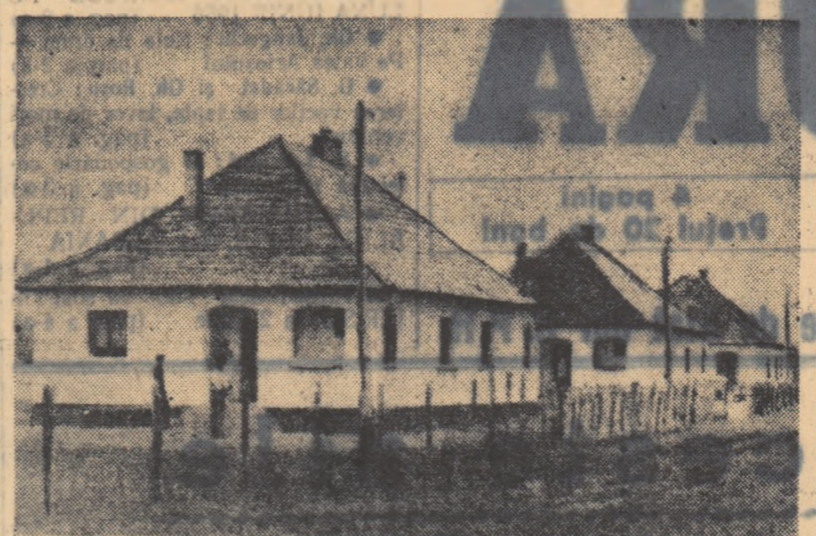
La gospodăria agricolă de stat Dîlga din regiunea București există multe preocupări pentru asigurarea unor condiții cât mai bune de muncă și de trai muncitorilor și tehnicienilor. De curînd a fost dat în folosință un nou grup de locuințe.
