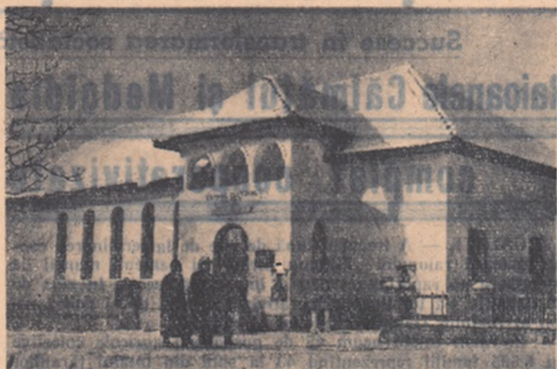
Noul cămin cultural din comuna Runcu, raionul Tg. Jiu, regiunea Craiova.
