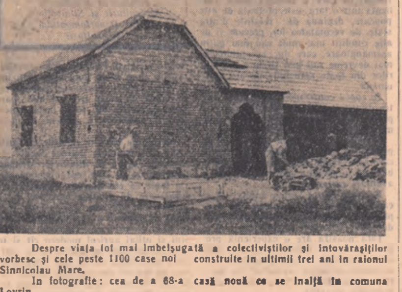
Despre viața tot mai îmbelșugată a colectiviiștilor și întovărășitorilor vorbesc și cele peste 1100 case noi construite în ultimii trei ani în raionul Sînnicolau Mare. În fotografie: cea de-a 68-a casă nouă ce se înălță în comuna Lovrin.
