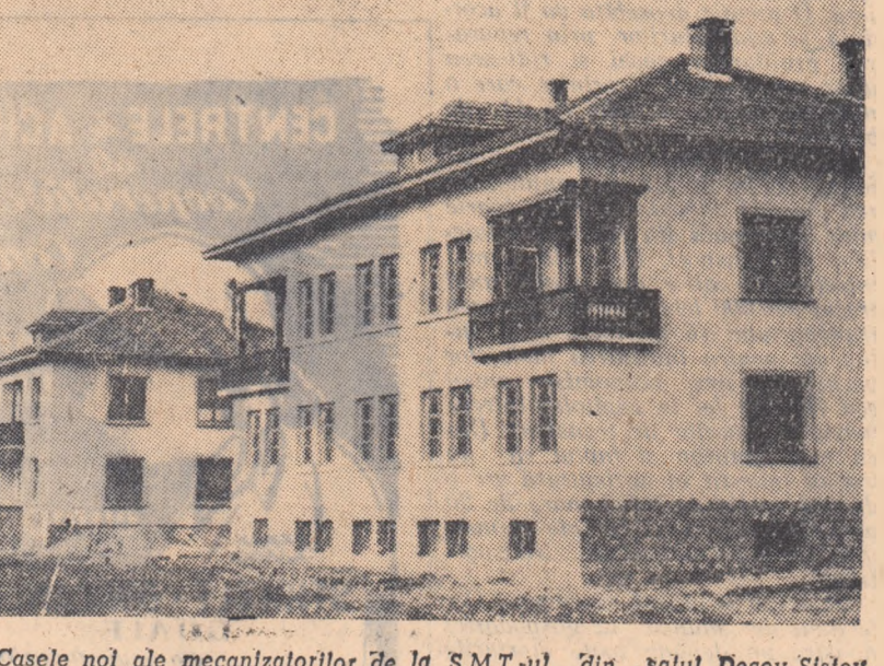
Casele noi ale mecanizatorilor de la S.M.T.-ul din satul Decov-Sislov
