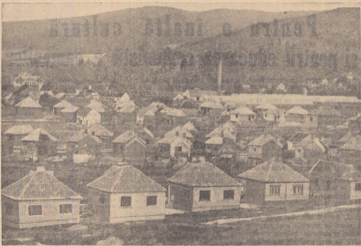
Viața fericită și îmbelșugată a membrilor gospodăriei colective „7 Noiembrie” din Codlea, regiunea Stalin, se vede și în numeroasele case ce le-au construit și mai sînt în curs de construire. În fotografie: aspect general din noul cartier al colectivizatorilor
