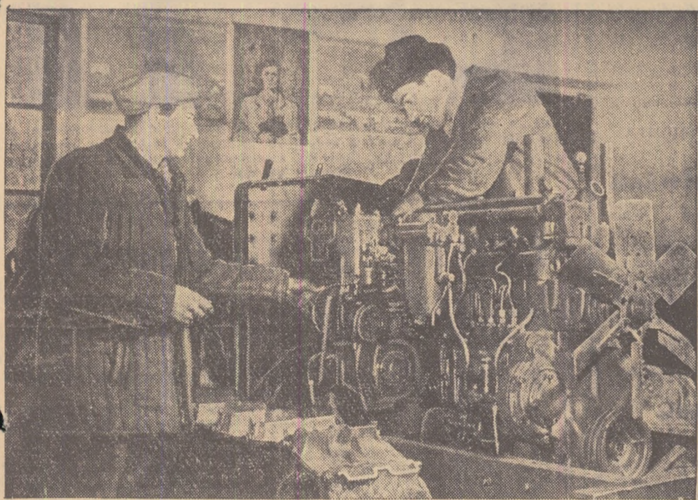
Mecanizorii S.M.T.-ului Podoleni, regiunea Bacău, se pregătesc intens pentru campania agricolă de primăvară. Ei au reparat până acum peste 60 la sută din numărul tractoarelor și circa 90 la sută din mașinile agricole. În clișeu: mecanicul controlor Ion Rustel și mecanicul Gheorghe Canache din secția montaj, efectuând controlul unui tractor K.D.-35.
