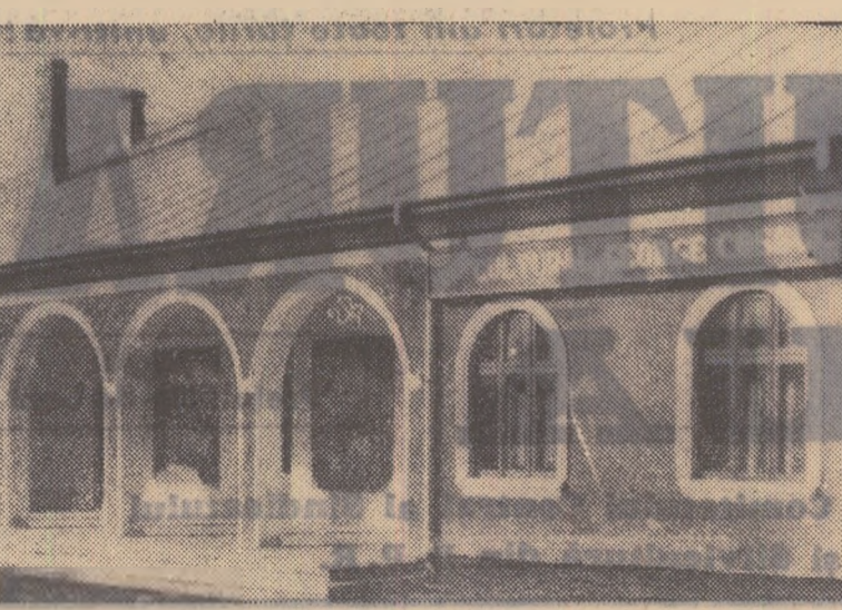
De curînd, comuna „23 August”, raionul Negru Vodă, s-a îmbogățit cu o nouă și frumoasă construcție destinată căminului cultural. Aici se desfășoară o vie activitate culturală.
