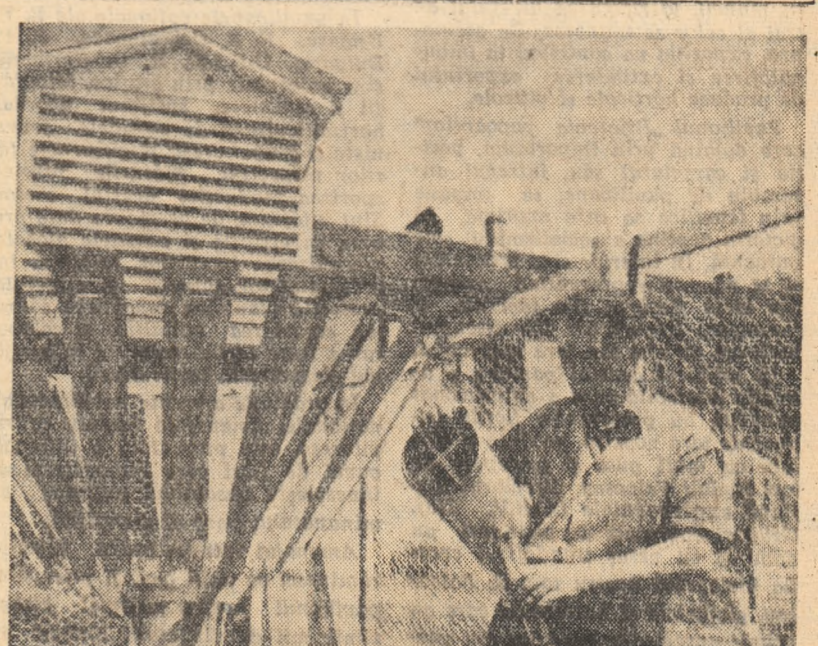
La Stația de avertizare a inundațiilor a gospodăriei de stat Corcova, regiunea Oltenia, Ing. George Constantinescu determină cantitatea de apă cîzului în ultimul timp.
