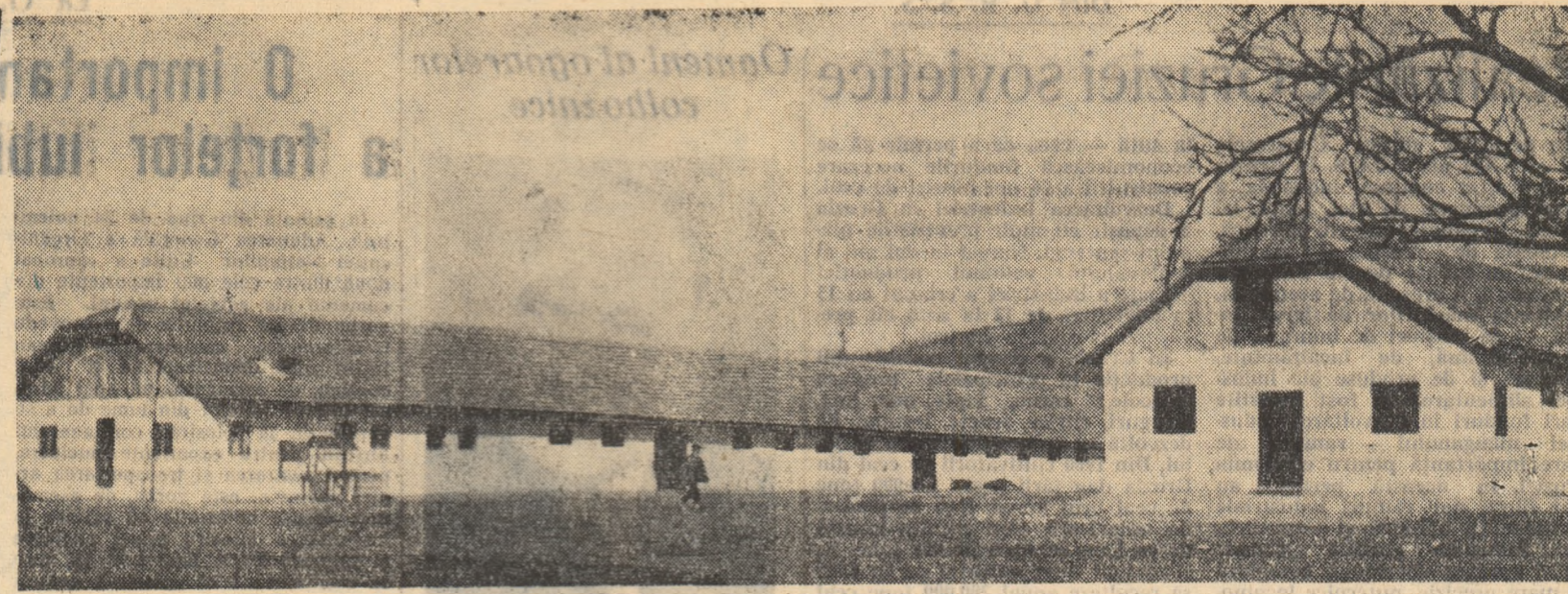
Noi construcții zootehnice la gospodăria agricolă colectivă din Sulești, raionul Drăgănești
