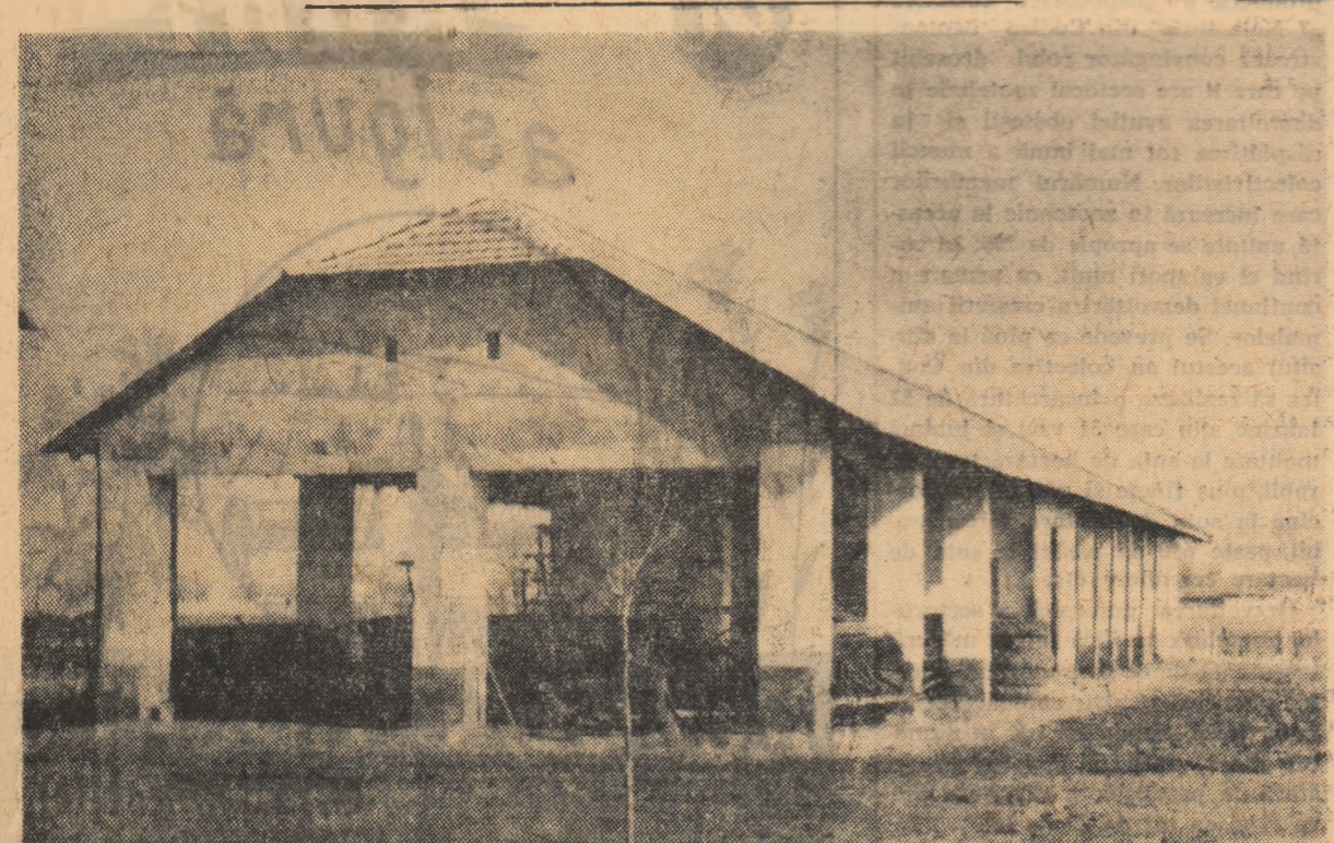
La marginea comunei Lenaueheim, alături de construcțiile G.A.C. își are sediul și tabăra brigăzilor permanente de la S.M.T. Gottlob. În fotografie: remiza-atelier ridicată anul trecut de către colectivști.
