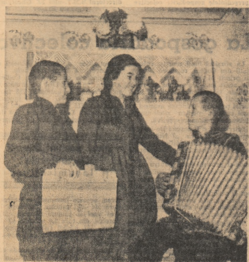
Ne aflăm în casa cea nouă a colectivistului Nicolae Popovici din comuna Muntenii de Jos — raionul Vaslui. Lui Ionel, părinții i-au cumpărat un acordeon, iar el a învățat repede numeroase cîntece pe care le execută deocamdată în fața celor al casei
