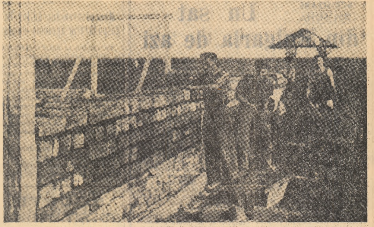
La G.A.C. Viața Nouă din Diosig, regiunea Crișana, construcțiile agricole se desfășoară din plin. În momentul de față se lucrează la ridicarea zidului pentru grajdul de vail.
