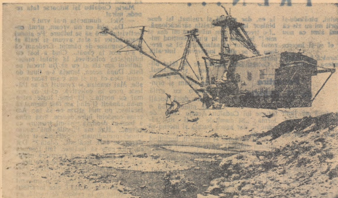
Pe malurile Angarei... Aici va fi construită hidrocentrala Bratsk, cea mai mare hidrocentrală din lume. Fotografia noastră înfățișează un uriaș excavator pășitor care lucrează pe șantierul construcției hidrocentralei.
