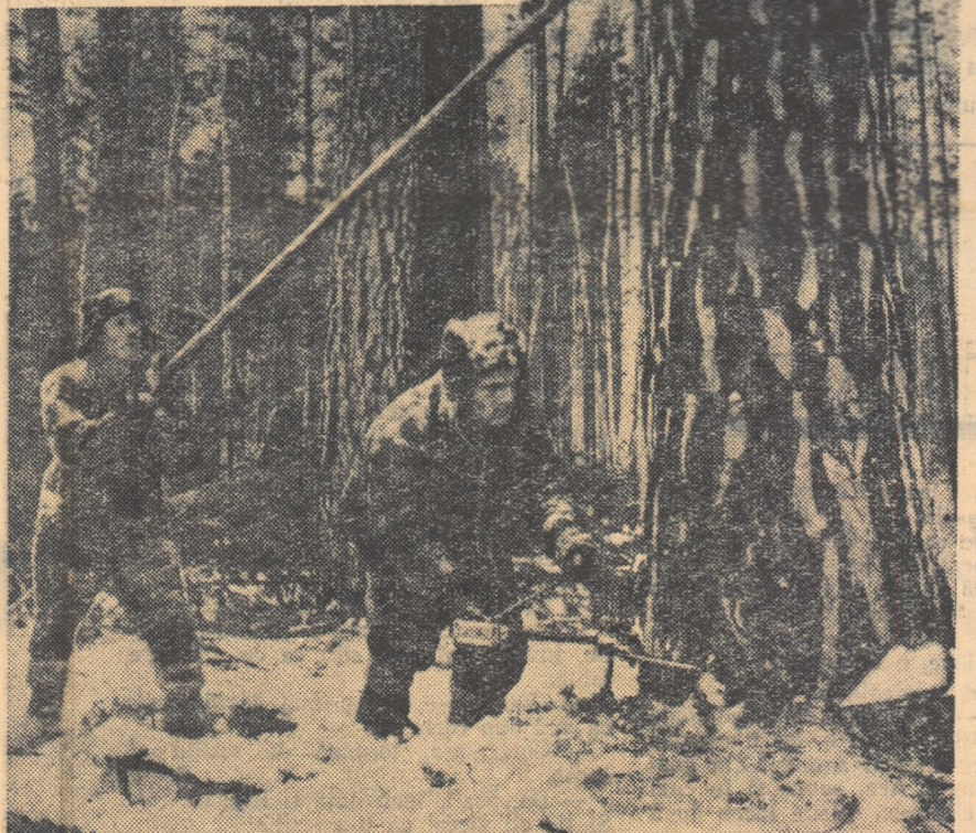
Construcția hidrocentralei abia a început și tăietorii de lemne doboară arborii seculari pentru a netezi fundul viitorului rezervor de apă. După construirea barajului, în locul acesta Angara se va ridica la o înălțime de cîteva zeci de metri.
