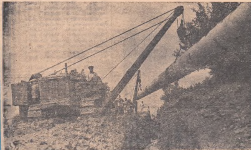
Noua conductă de gaz melan Nadeș-Onțești va duce gazul melan din Ardeal în Mol- dova. Muncitorii de pe șantierul nr. 3 conducte — O.122 s-au montat pînă în prezent peste pînă 3000 metri linizii de conductă.
