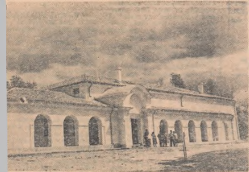
Noul cămin cultural din Slobozia-Mindra, construit prin contribuția plutară a oamenilor din comună.
