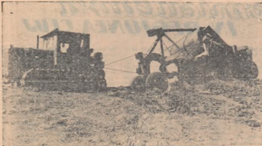
Pe șantierul din raionul Jimbolia, în ajutorul miilor de muncitori, țărani, colectivști și întovărășiți care lucrează la canalele de desecare, au fost trimise tractoare și mașini-unelte de mare capacitate. Acestea lucrează îndeosebi la desfundarea albiei riurilor Beregsău și Bega Veche.
