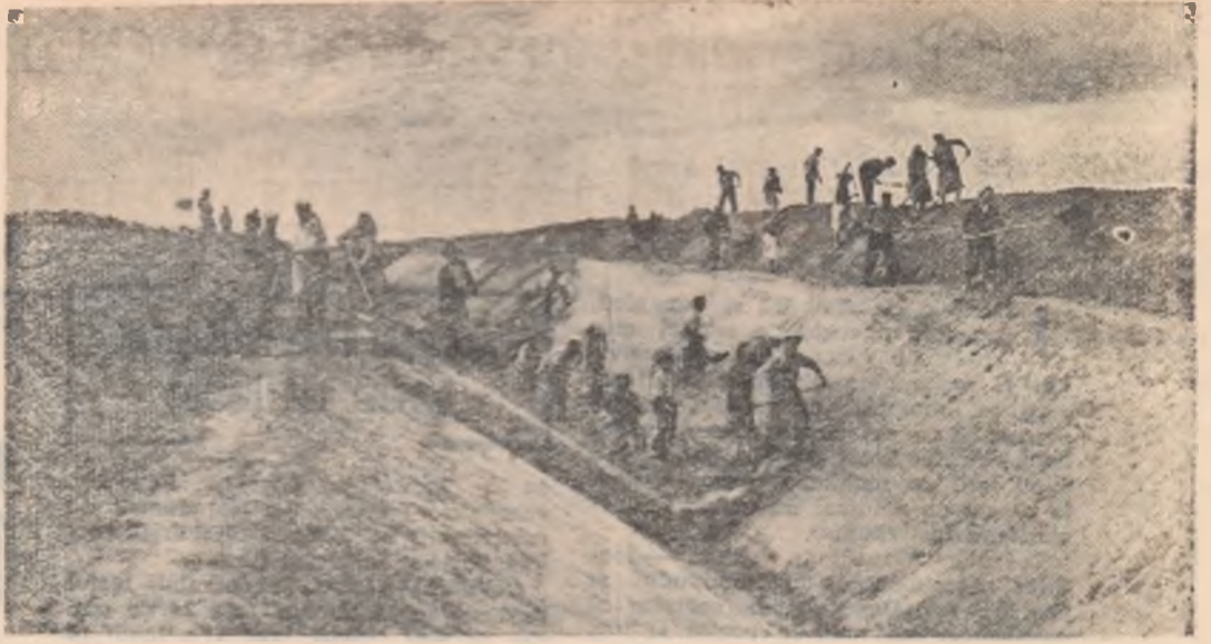
Pe șantierul de la Luciu-Giurgeni se muncеște cu însuflețire pentru terminarea lucrărilor.
