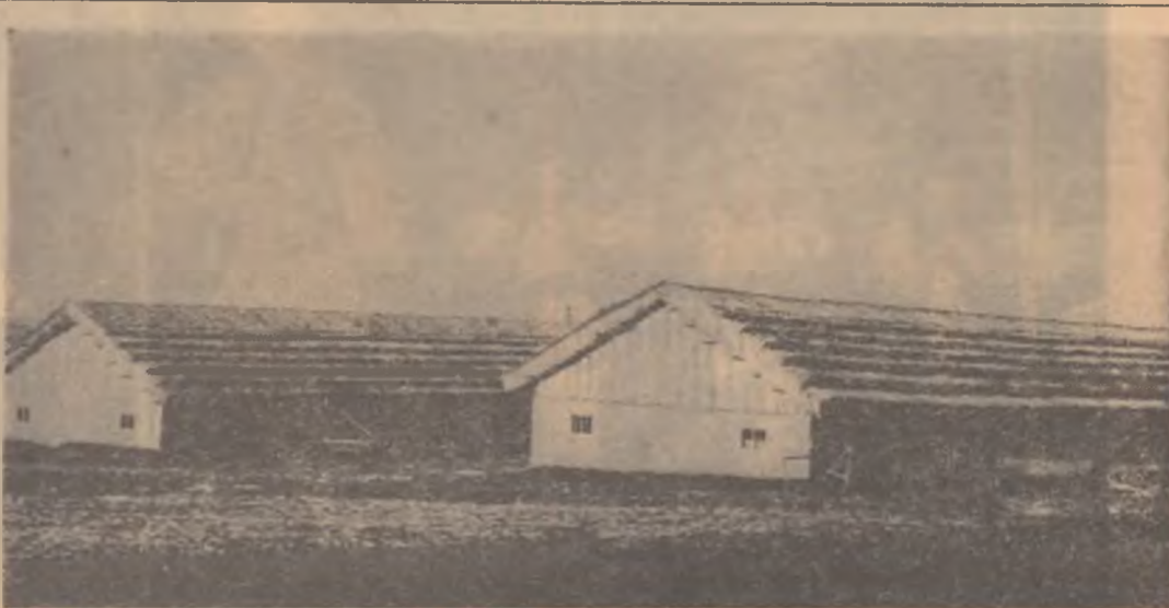
Construcții ieftine de grajduri din resurse locale. La trei astfel de grajduri colectivității din comuna Independența, regiunea Galați, au realizat o economie de 120.000 lei.
