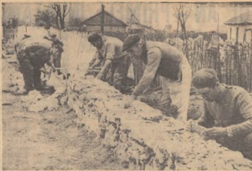
Acțiunea de înfrumusețare a comunelor și satelor regiunii Dobrogea este în plină desfășurare, construindu-se garduri și pavaje cu piatră. Echipa de zidari, condusă de Eregap Gheldi de la G.A.C. Topraisar execută zilnic 33 metri liniari de gard.
