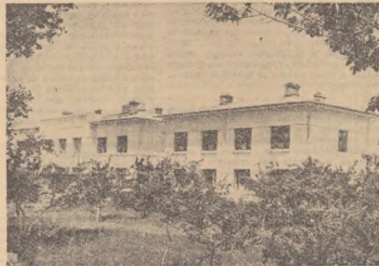
Spitalul recent construit în comuna Măicînești, raionul Liești.
