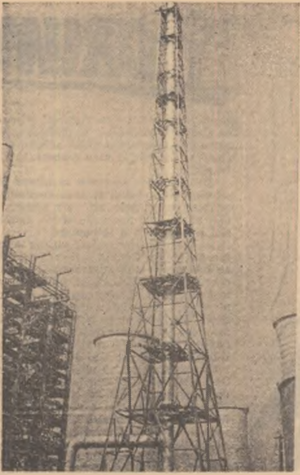
Duza, înaltă de peste 100 metri, de evacuare a gazelor
