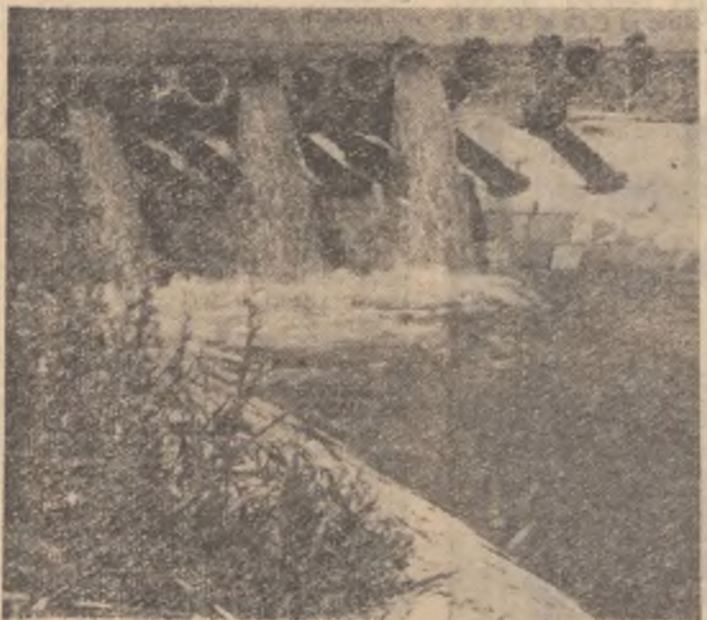
Sistemul de irigație Stoenești-Scărișoara, regiunea Craiova, dat parțial în exploatare la 20 mai a.c. va asigura irigarea unei suprafețe de 2.000 hectare. În fotografie: gurile de alimentare cu apă a canalului principal de irigare de la stația Stoenești, raionul Caracal.
