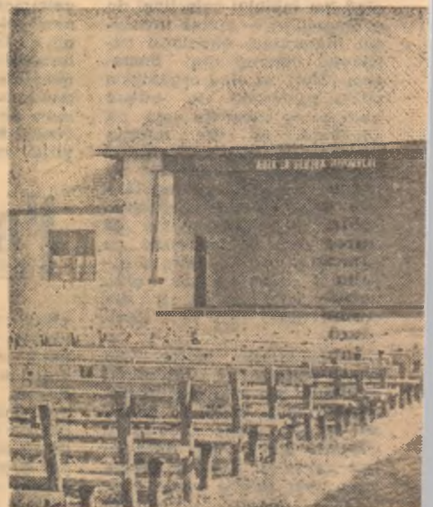
Teatrul de vară recent construit de către
