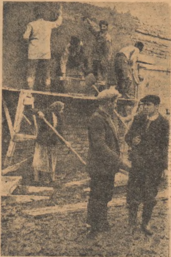
Se execută ultimele lucrări de finisaj la o nouă clădire
