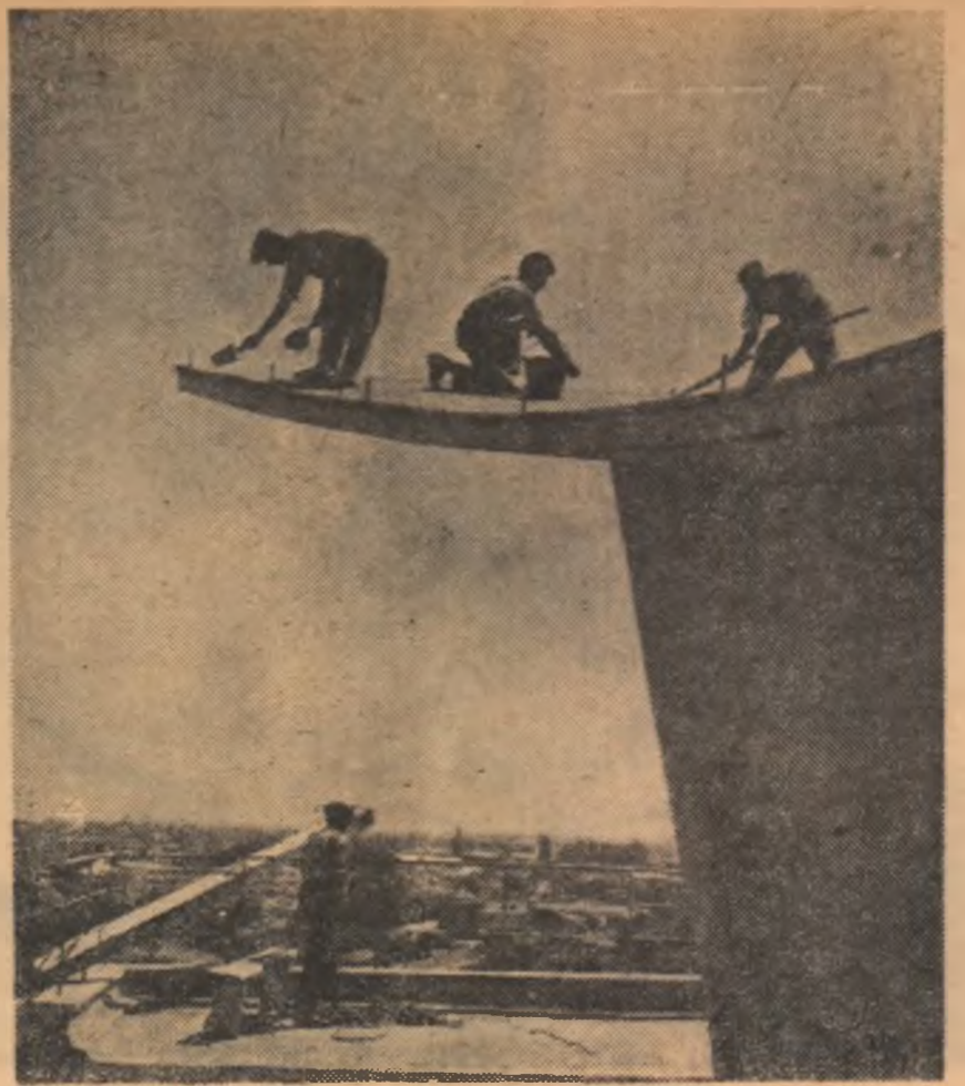
O aripă de avion sau o punte de vapor? Nu! Este vorba de liniile și planurile îndrăzneț și armonios dispuse ale terasei unui nou bloc de locuințe din București.
