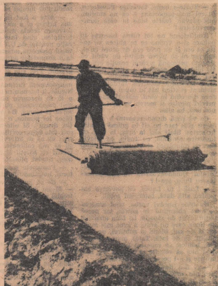
Aspect de muncă din Thailanda. Nivelarea terenului pentru extragerea sărîi din apa de mare se face cu mijloace rudimentare care cer din partea muncitorilor eforturi fizice mari.
