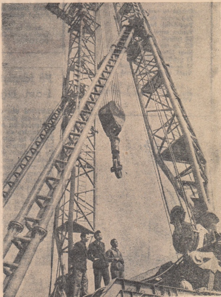
4 L D, construită la uzinele „1 Mai” din Ploiești, se exportă în numeroase țări, fiind apreciată ca una din cele mai moderne instalații de foraj din lume
