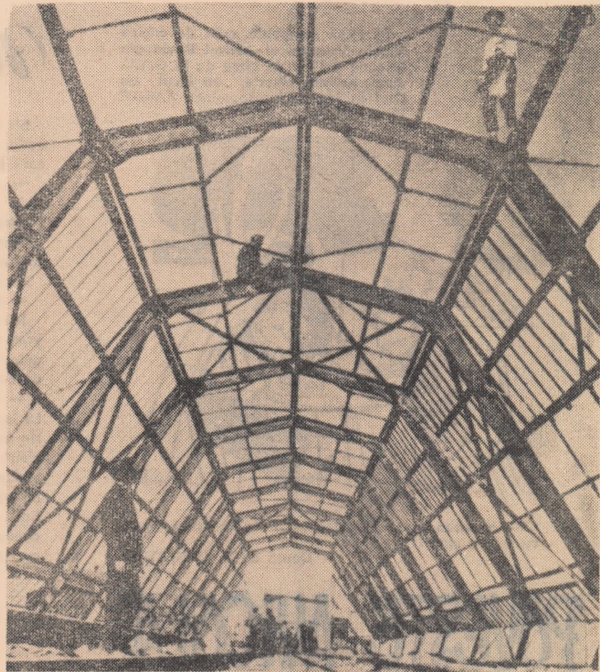
Construcția platoului de descărcare pe șantierul unei uzine chimice din Kazahstanul de sud.
