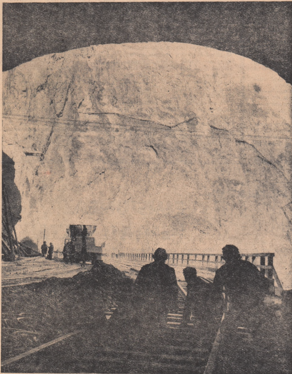
Construirea căilor de comunicație deasupra barajului Hidrocentralului „16 Februarie” de pe Argeș
