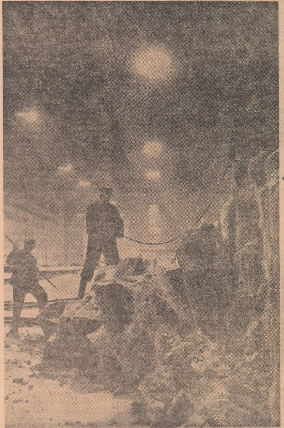
Salina „Slănic Prahova”, exploatarea sării într-un abataj frontal.
