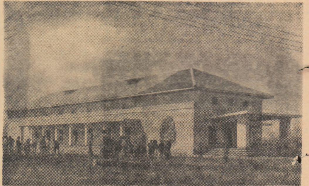
Clădirea căminului cultural din comuna Mihail Kogălniceanu — Medgidia.
