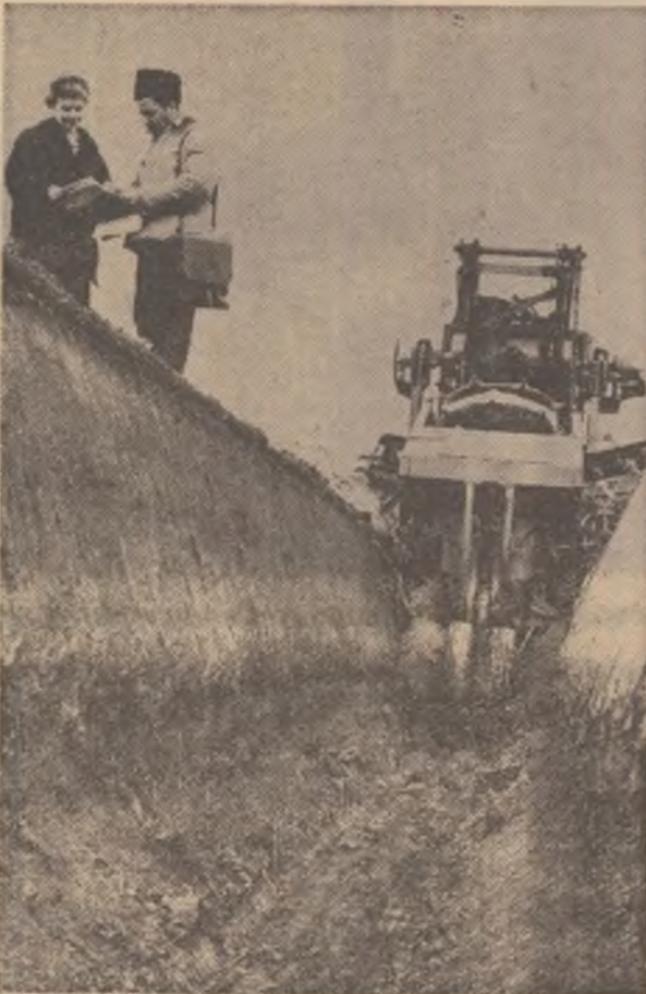
Lucrări de escavare în sistemul de irigații de la Jegălia, județul Ialomița.
