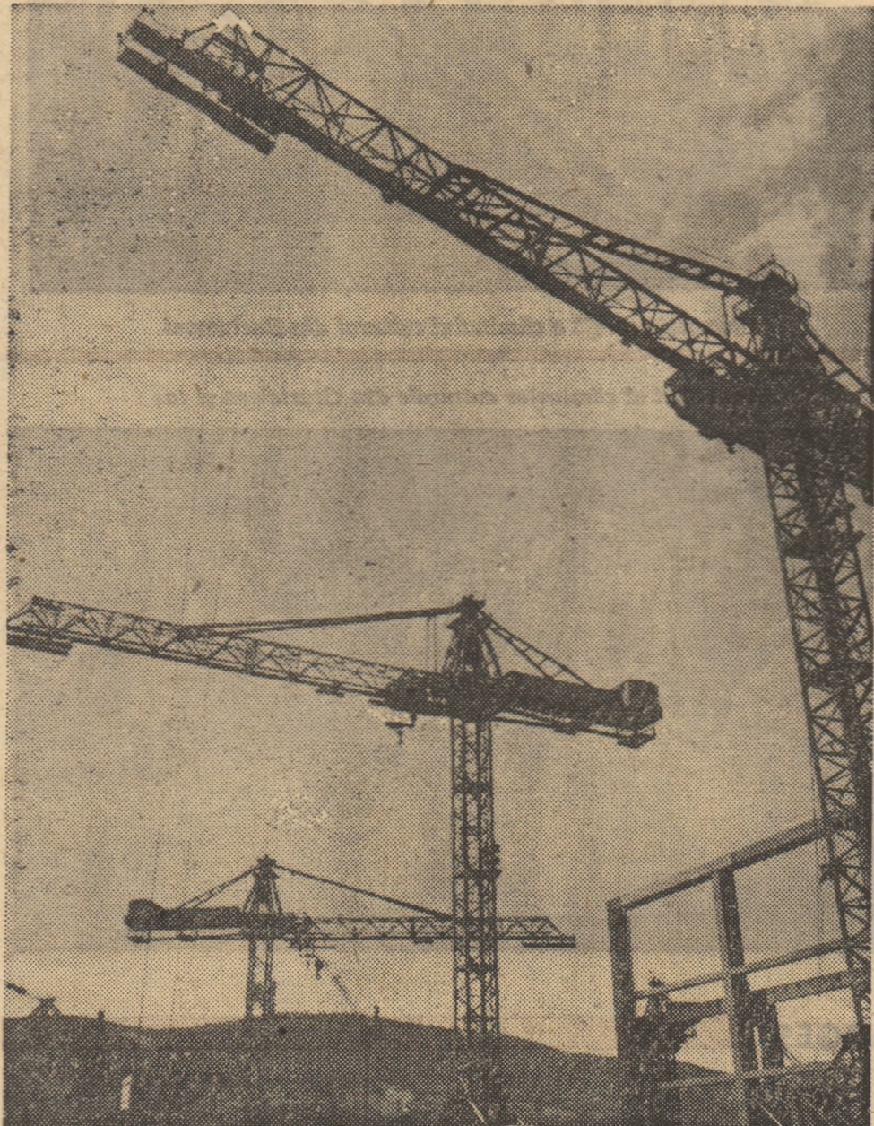
Sistemul hidroenergetic Porțile de Fier
