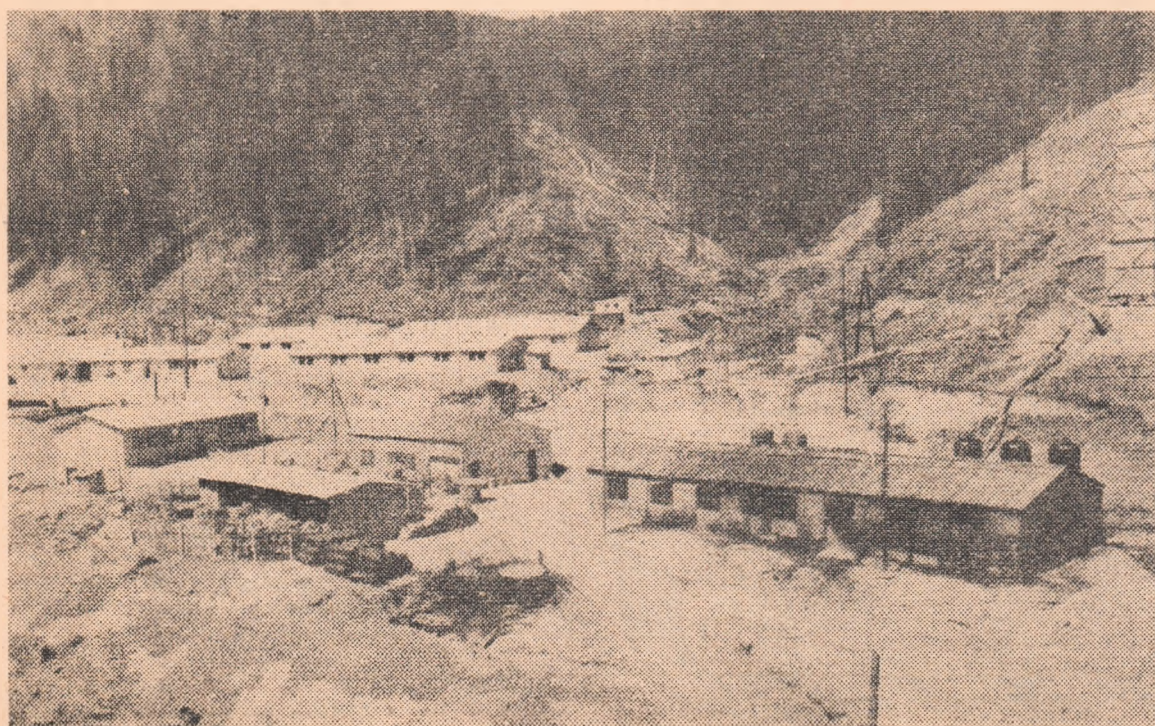
COLONIA CONSTRUCTORILOR DE LA MÎNILEASA
